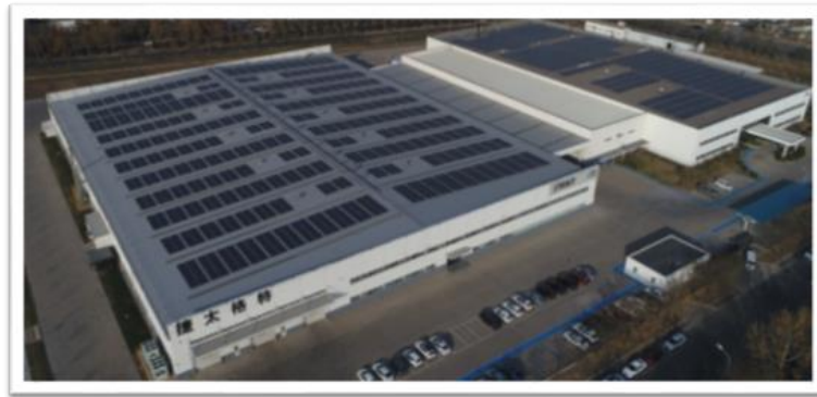
太阳能光伏板俯瞰图
